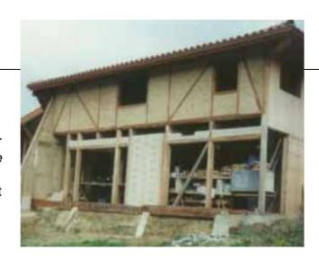
**Serre au Sud** : (*ci-contre*), couverte d'une avancée de toit calculée pour l'ombre d'été, munie d'ouvrants en partie haute pour les surchauffes, équipée de volets roulants pour l'isolation nocturne d'hiver.
