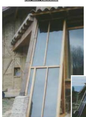
**Eau chaude sanitaire**: (cicontre à gauche) chauffe eau solaire en thermosiphon (sans pompe ni régulation).
