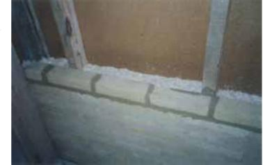
**En toiture**, l'isolation doit être maximale (ici 35 cm de paillettes de chanvre en vrac).
